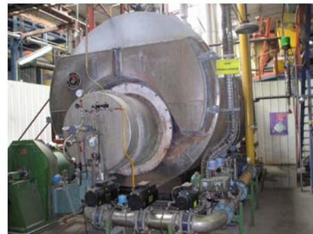
La chaudière alimentée par le biogaz
