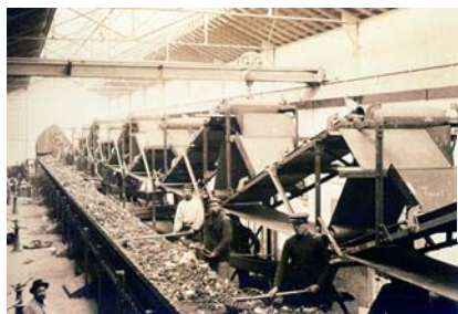
Hall des broyeurs à Vitry sur Seine : des ouvriers attirent la gadoue dans la trémie placée au-dessus de chaque broyeur.
