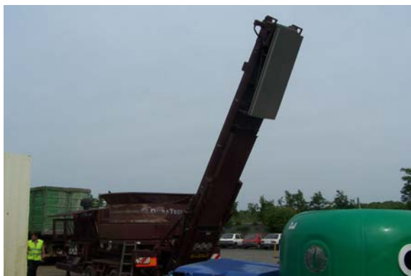
Overband pour séparation du fer par magnétisme
