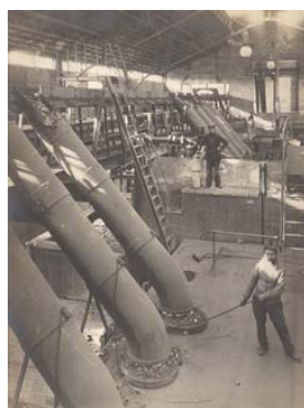
La gadoue est acheminée par un transporteur et aiguillée par des ouvriers pour remplir les goulottes d'alimentation des fours. Quatre portes sont percées dans la façade de chaque four et permettent aux ouvriers d'opérer l'étagage de la gadoue et d'enlever les mâchefers
