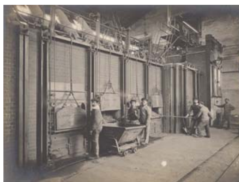
La gadoue est acheminée par un transporteur et aiguillée par des ouvriers pour remplir les goulottes d'alimentation des fours. Quatre portes sont percées dans la façade de chaque four et permettent aux ouvriers d'opérer l'étagage de la gadoue et d'enlever les mâchefers
