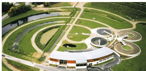
Station d'épuration d'Honfleur
